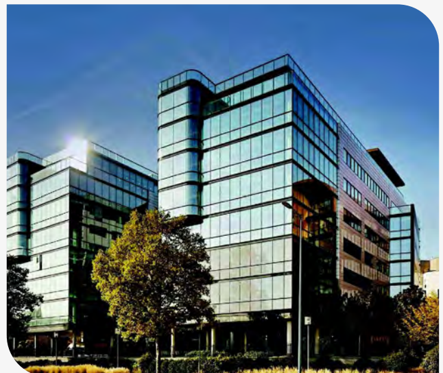
Immeuble « Seine Avenue » - Portefeuille PERIAL Grand Paris
