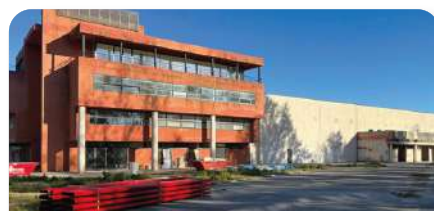
Gérone (Espagne) 14 151m 2 | entrepôt logistique Taux d'occupation : 100% Monolocataire Acquis le 17 avril 2024
