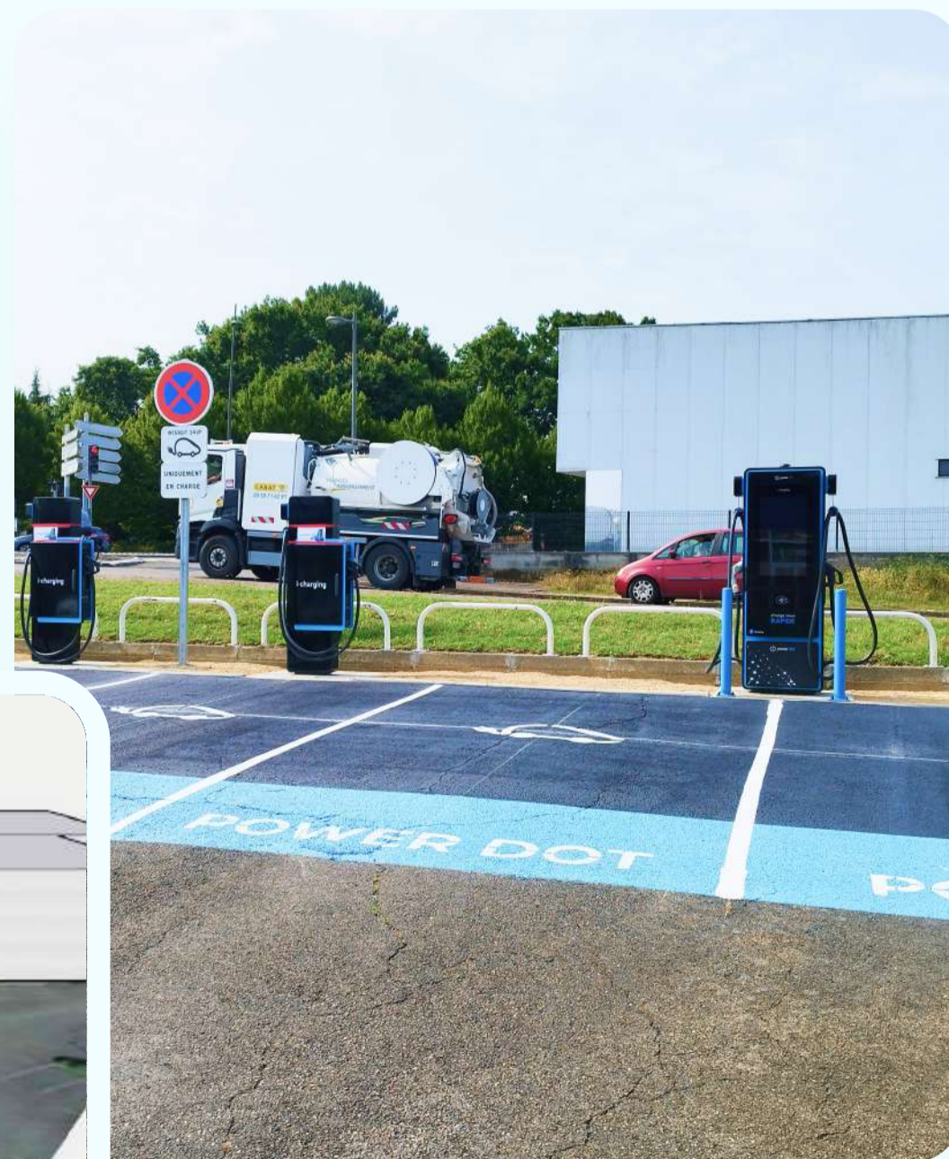
Installation des bornes de recharge pour véhicule électrique à Mont de Marsan
