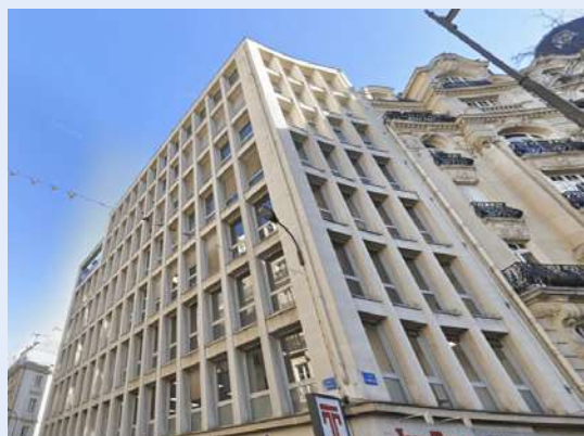
36 Rue Brunel-Paris (17 ème ) - Immeuble
