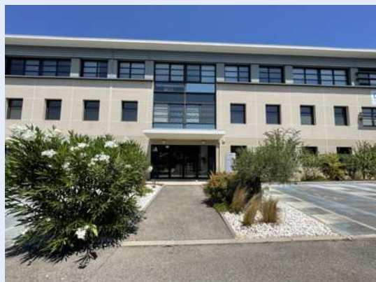
Les Pléiades III - 320 avenue Archimède - Aix-en-Provence (13)
