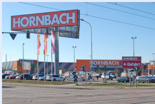
Hornbach - Delitzscher Straße 54 - Halle-sur-Saale (Allemagne)
