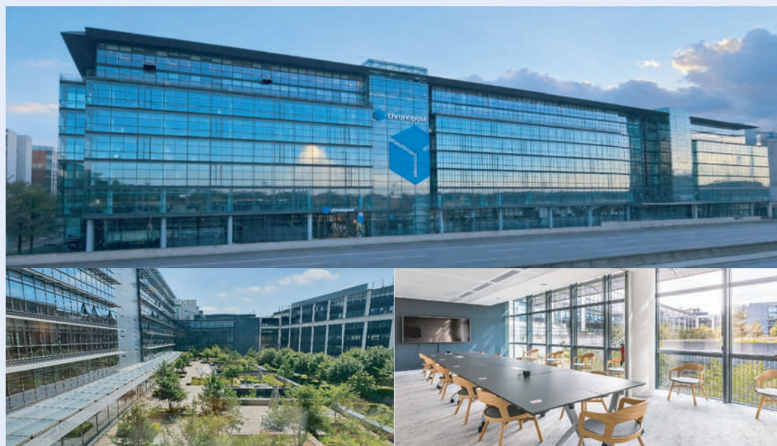
Immeuble Magnetik - Boulevard Romain Rolland - Paris 14 ème
