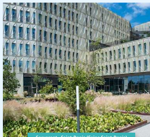
Coruscant - Saint-Denis (Seine Saint-Denis)
