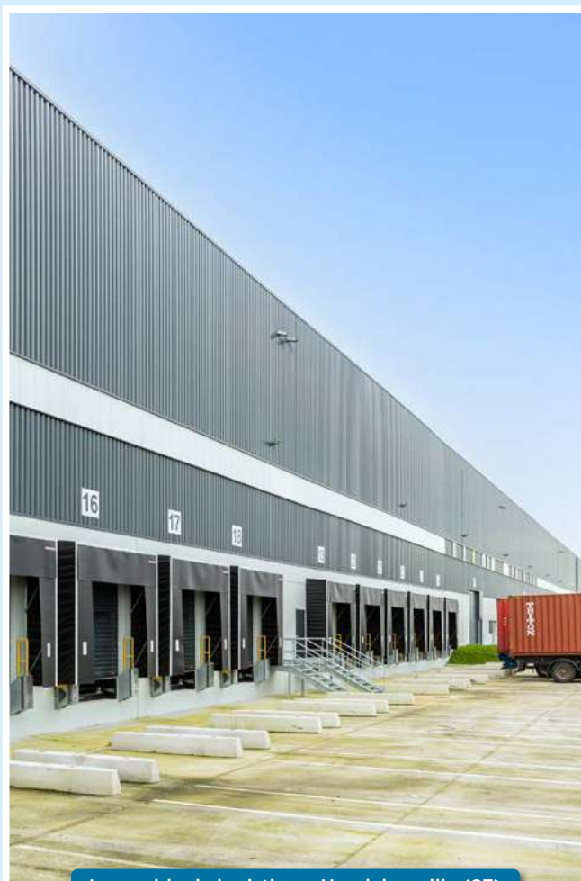
Immeuble de logistique, Heudebouville (27)
