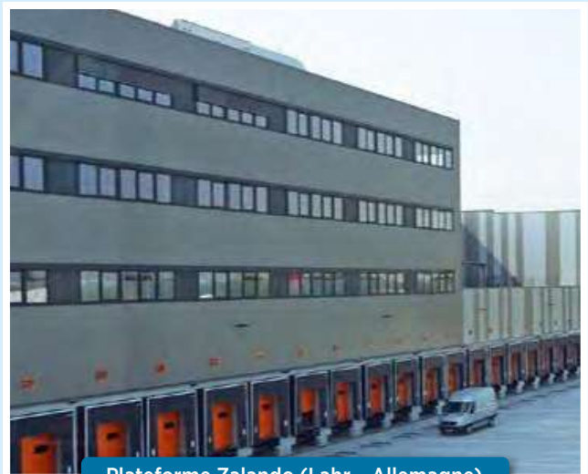
Plateforme Zalando (Lahr – Allemagne)
