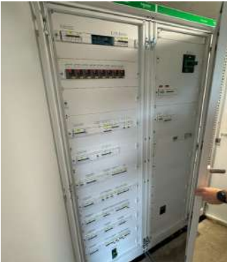
Remplacement du TGBT
