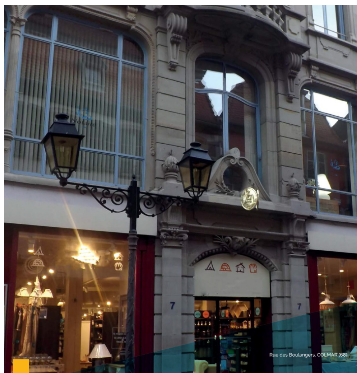
Rue des Boulangers à COLMAR (68)
