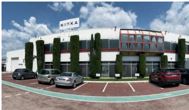
Bureaux & entrepôts - Aubagne
