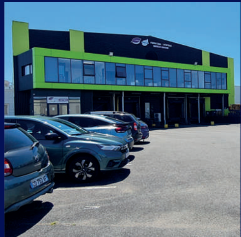
Zone d'activité - Vayres (France) Crédi photo : Ressource
