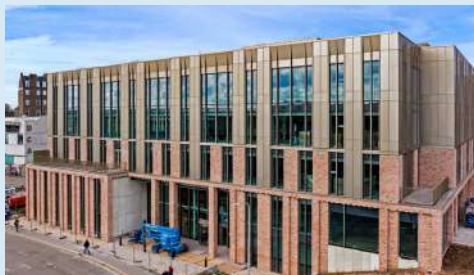
Immeuble de bureaux loué à BT (British Telecom) – Dundee, Royaume-Uni
