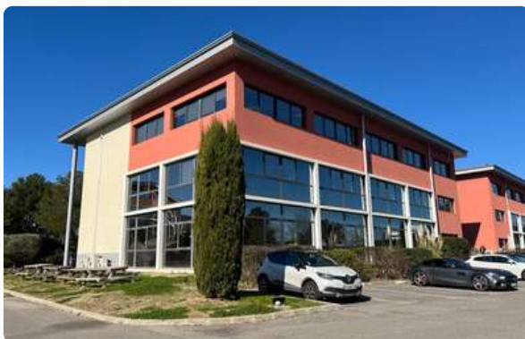
L'actif d'Aix-en-Provence pour lequel nous lançons une campagne de travaux de Gestion Technique du Bâtiment
