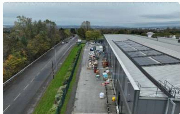
Panneaux photovoltaïques sur l'actif situé à Glasgow.
