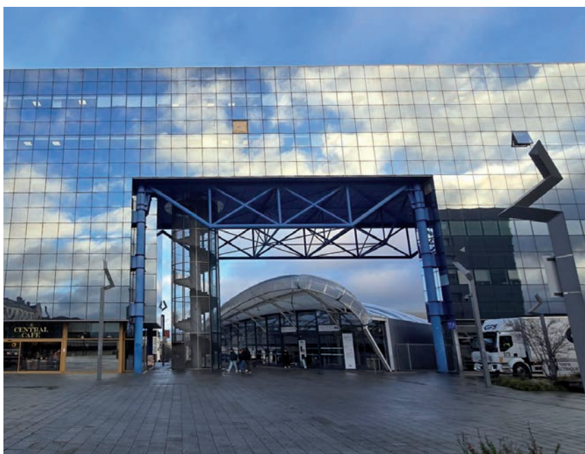
Gare Sud - Rennes
