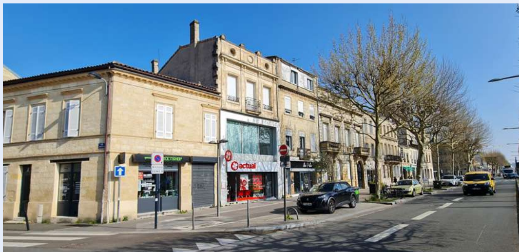
46 Avenue Thiers — Bordeaux (33100)
